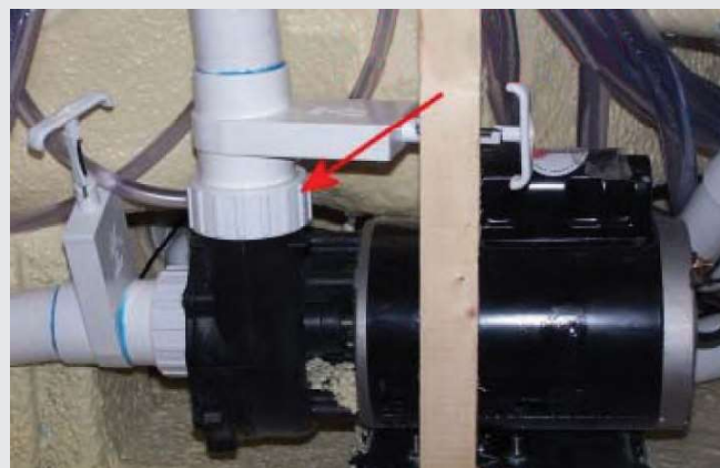
FIGURE 1.2b : BAGUE DE POMPE ; DESSERREZ POUR LAISSER S'ÉCHAPPER L'AIR
